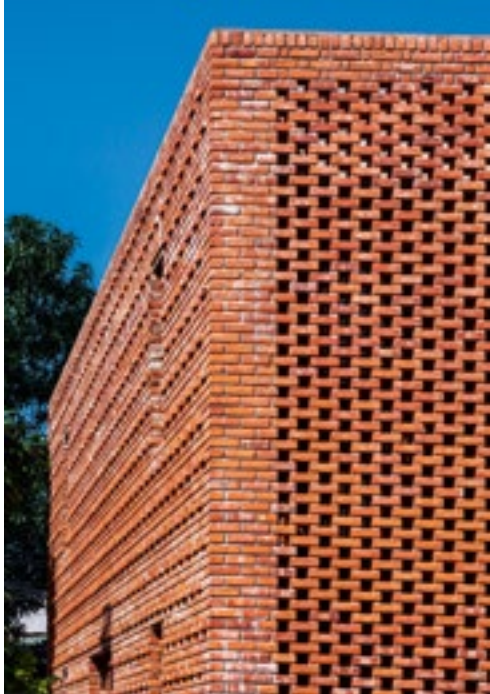
▲ Backstein innen wie außen und poröse Wände als Steuerungselement für das Raumklima: Das Termitary House von Tropical Space (Vietnam) – Goldwinner beim Fritz-Höger-Preis 2017 – nutzt das Mauerwerk zur Belüftung.
