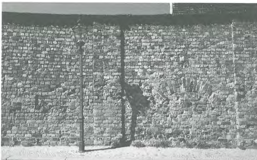
14. Jh. Spandau (Kolk) Hoher Steinweg Stadtmauer
