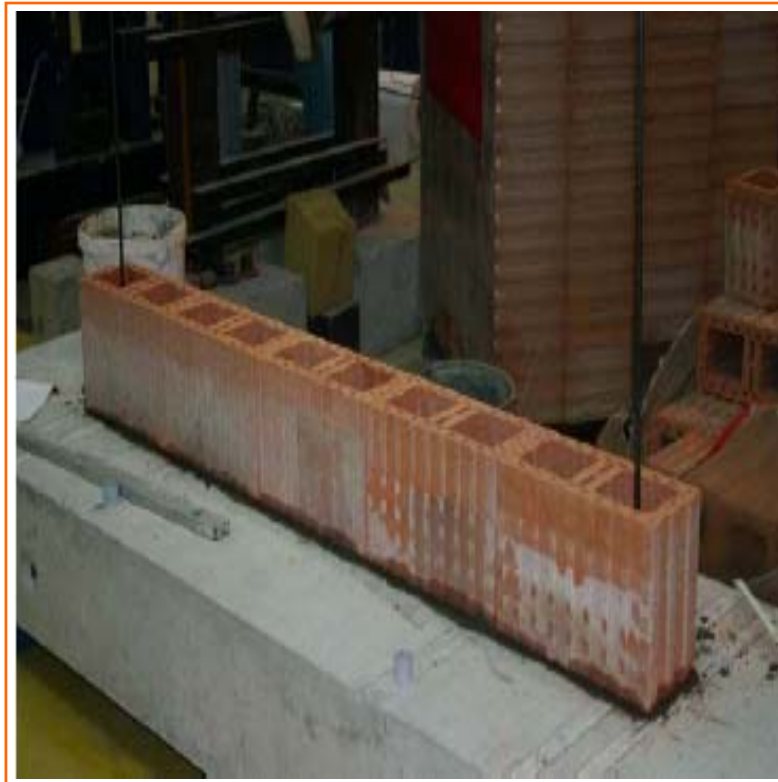
Bild 5: Probekörper [3] während der Herstellung.
