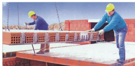
Abb. 2: Montage der Deckenfertigteile
