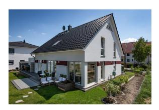
Bild 2: Massives Einfamilienhaus, errichtet von Helma Eigenheimbau in Blankenfelde-Mahlow (Land Brandenburg). Die monolithische, aus porosierten Hochlochziegeln aufgebaute Wand erhielt eine weiße Putzfassade. Eine helle Farbe reflektiert die Sonneneinstrahlung bekanntlich stärker als eine dunkle. Mit dem Ergebnis, dass sich im Sommer die Gebäudehülle weniger stark aufheizt. Foto: Helma Eigenheim AG / Claudius Pflug
