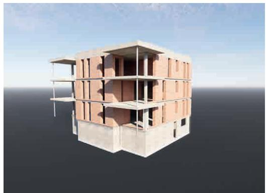
**Bild 13.** Digitaler Zwilling des Pilotprojekts – Gebäudekubus mit konkretisierter Raum- und Baumaterialplanung (Entwurfsplanung) (Bildquelle: Grimm GmbH)
